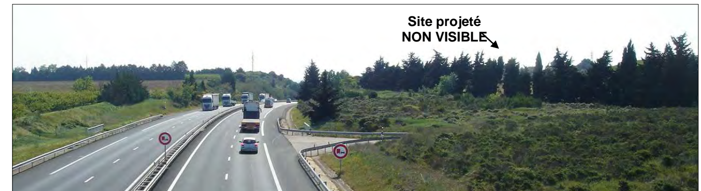
Photo n°25 - Vue depuis le pont enjambant l'A54
