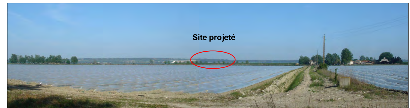
Photo n°10 - Vue au niveau du domaine de Marsane
